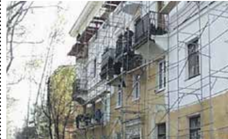
Очередность проведения капитального ремонта многоквартирных домов определяется в региональной программе
