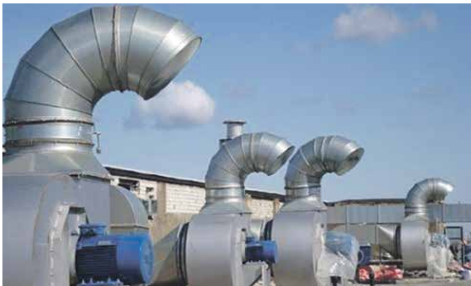
Системы дымоудаления и противопожарной автоматики обслуживают управляющие организации. Надзор за этими системами осуществляют органы Государственного пожарного надзора
