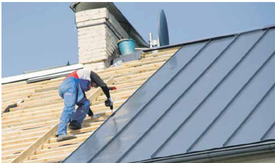
Замена кровли крыши – это вид капитального ремонта многоквартирного дома
