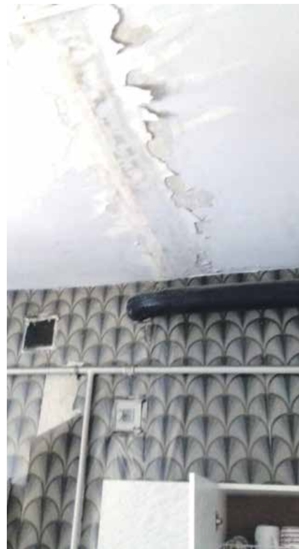
Недавно отремонтированный потолок вздыбился и лопнул. А стены на кухне не просыхают всю зиму
