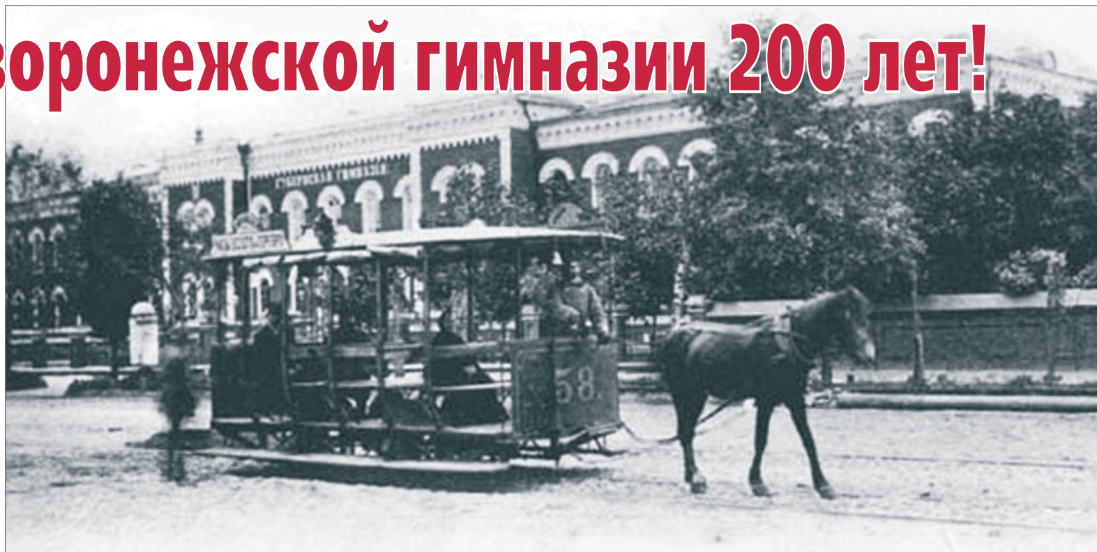
Первая мужская губернская гимназия располагалась в «старом» здании Технологической академии (ул. Сакко и Ванцетти, 102)
